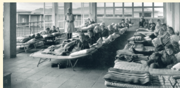
Neben den Klima- und Liegekuren in den Liegehallen, die übrigens linker Hand bei der Einfahrtstraße in die Fachklinik noch erkennbar sind, operierte man hier bereits in den 30er Jahren die Halslymphknoten-tuberkulose, damals übertragen durch die Rindertuberkulose.
