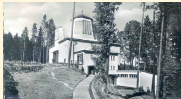
Nach der ersten großen Renovierung im Jahr 1952 entstand im Jahr 1954 der Kirchenneubau, heute als Cafeteria genutzt, der Glockenturm gehört einfach zur Wangener Stadtsilhouette!
